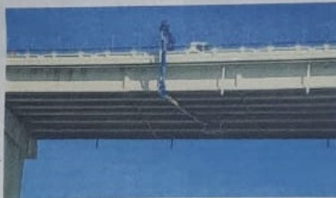
Gli operai al lavoro sul viadotto del Salinello
